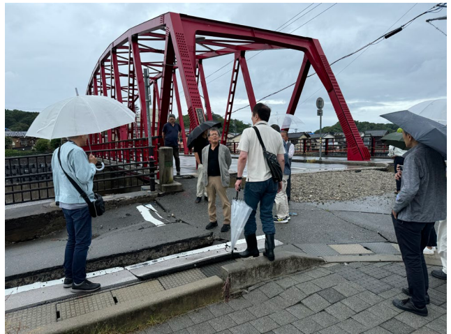
いろは橋と道路の段差を砂利で仮復旧されている様子
