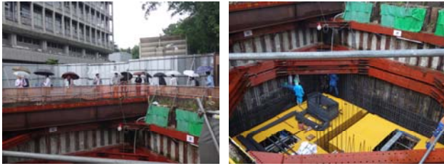
松川貯留施設の工事現場
