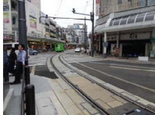
路面電車の延伸部
