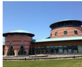
サンウエルの外観
