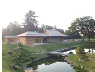
ほぼ完成している休憩所
