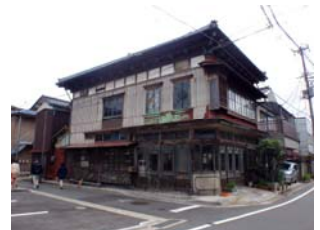
大正14年築 もと床屋建物
