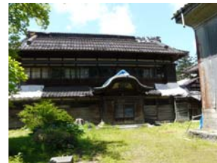
機那サフラン酒本舗離れ外観
